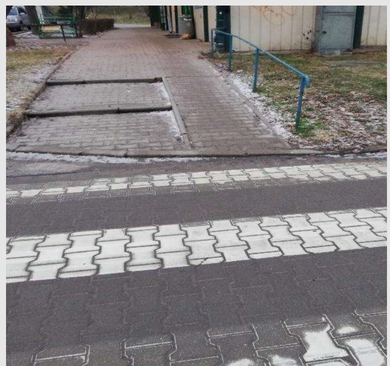
Zdjęcie 2 i 3. Schody i pochylnia wychodzą na wyniesione przejście dla pieszych. Brak jakiegokolwiek strefy zatrzymania, płynnego połączenia między wyniesieniem przejścia.
