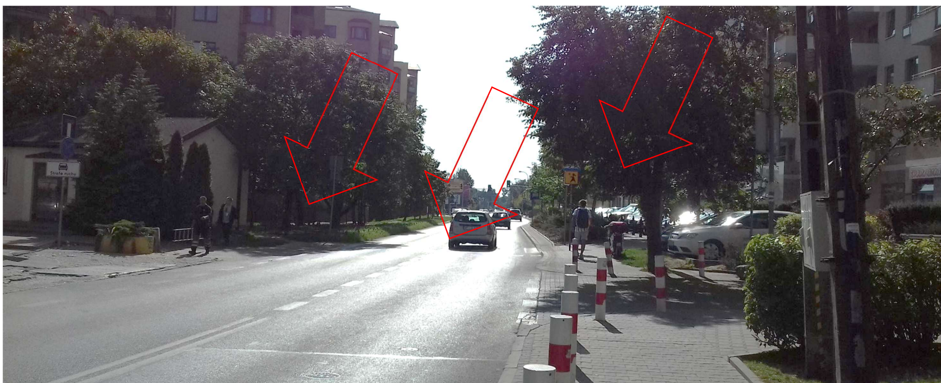
Przykład 6. Cień drzew powoduje, że pieszy zbliżający się do przejścia i wchodzący na przejście nie jest widoczny dla kierowcy. Kierowca oślepiony przez słońce nie widzi oznakowania pionowego i poziomego przejścia.
