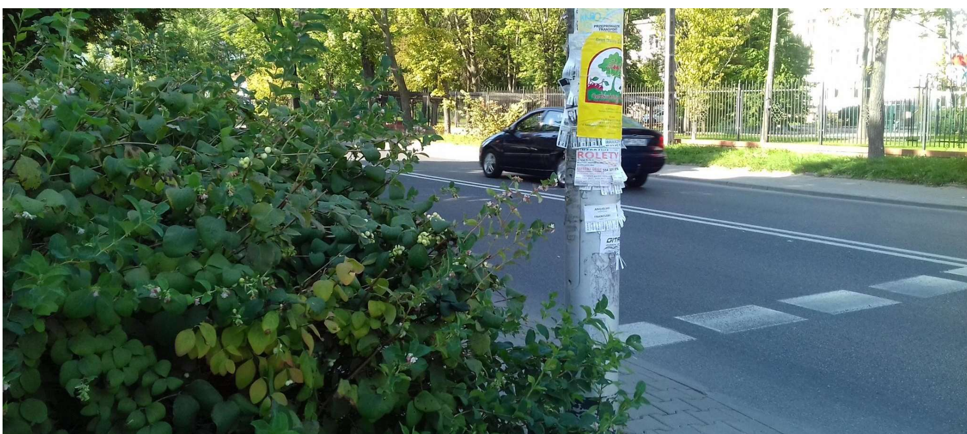
Przykład 8. Zieleń ogranicza widoczność, zasłania pieszego zbliżającego się do przejścia dla pieszych. Zieleń zasłania oznakowanie pionowe przejścia.
