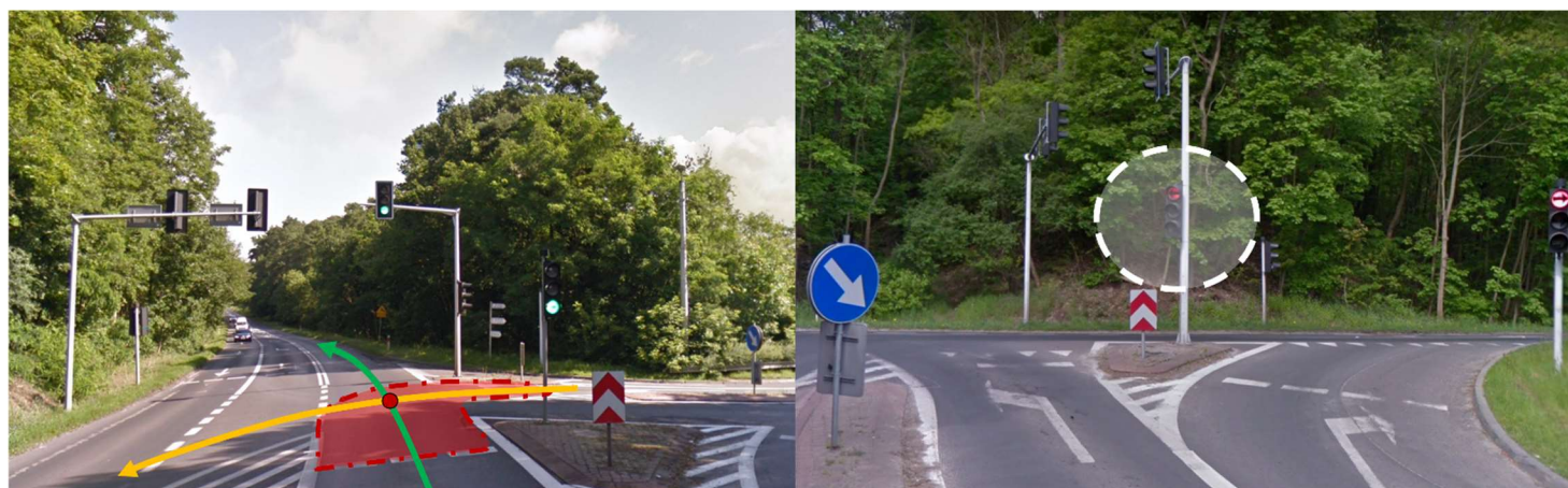
Fot. 2. Widok z wlotów skrzyżowania (uwagi do wlotu wschodniego: brak sygnalizatora nad jezdnią z ekranem kontrastowym, linia zatrzymań za blisko) Źródło: opracowanie własne na podstawie Google Street View [52.280433, 16.848271]
