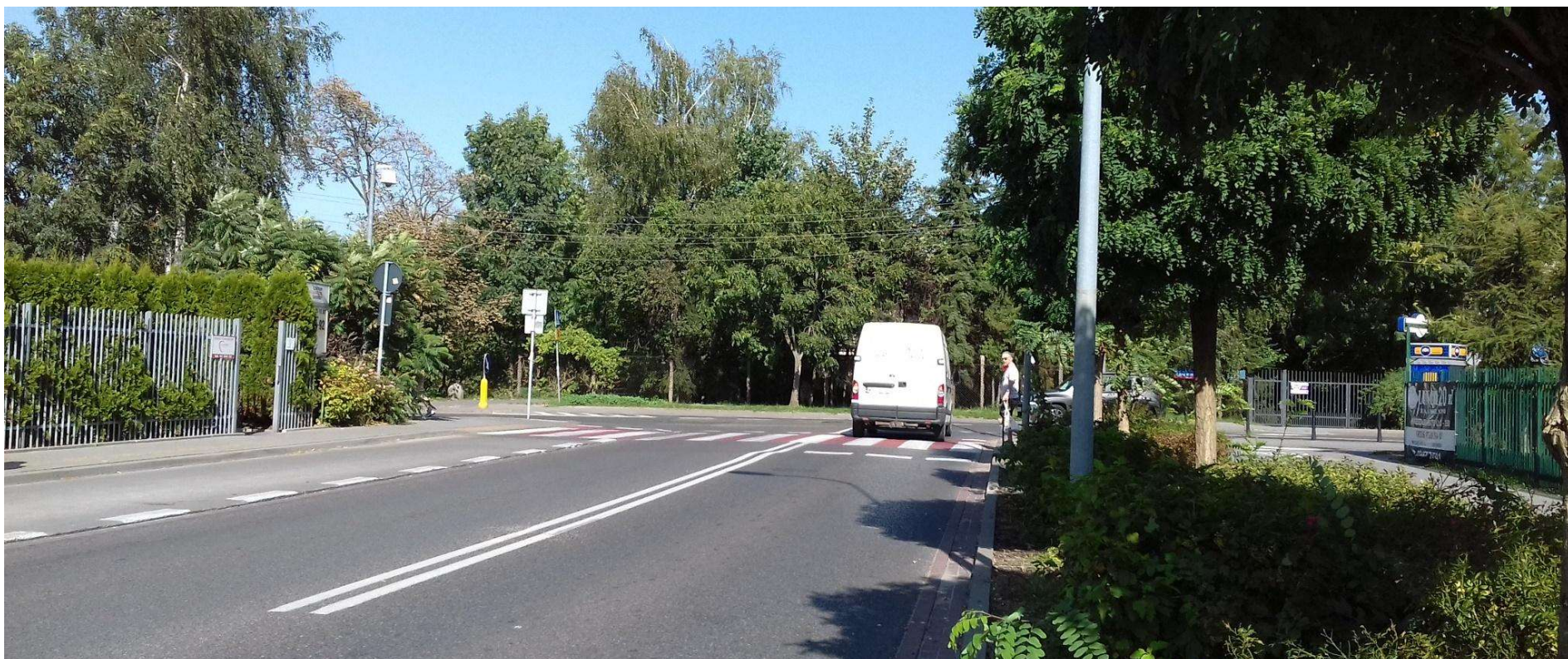
Przykład 10. Słup, drzewa sprawiają, że nie widać pieszego zbliżającego się do przejścia.
