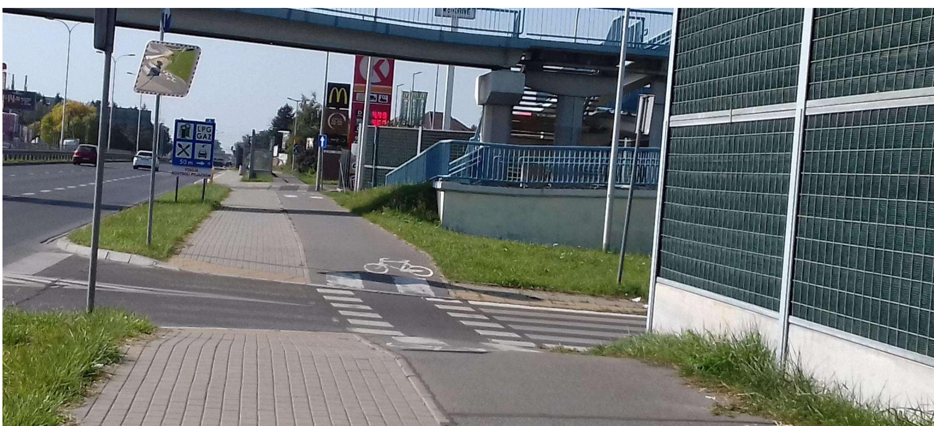
Przykład 9. Ekran akustyczny powoduje ograniczenie widoczności. Niechronieni uczestnicy ruchu (piesi, rowerzyści, osoby poruszające się na hulajnogach, urządzeniach transportu osobistego lub urządzeniach wspomagających ruch) nie są widoczni. Kierowca jadący drogą podporządkowaną nie ma czasu na reakcję.
