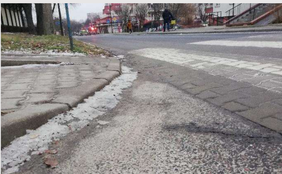
Zdjęcie 2 i 3. Schody i pochylnia wychodzą na wyniesione przejście dla pieszych. Brak jakiegokolwiek strefy zatrzymania, płynnego połączenia między wyniesieniem przejścia.
