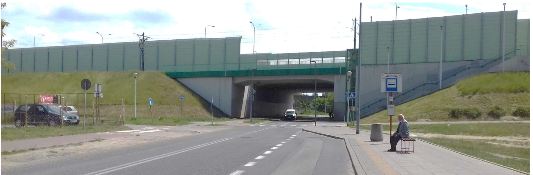
Przykład 1. Brak widoczności – rowerzysta z dużą prędkością wjeżdża zza schodów na przejazd rowerowy pod koła pojazdu wyjeżdżającego z tunelu. Niekonsekwentnie prowadzony ruch pieszy i rowerowy. Piesi korzystają z drogi rowerowej.
