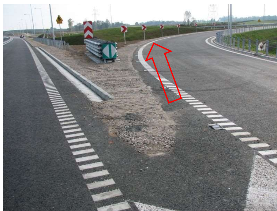
Zdjęcie 8 i 9 Wyłączenie łącznicy. Brak barier. Strome skarpy i wysoki nieosłonięty nasyp. Wypadnięcie z łuku grozi spadnięciem z nasypu.
