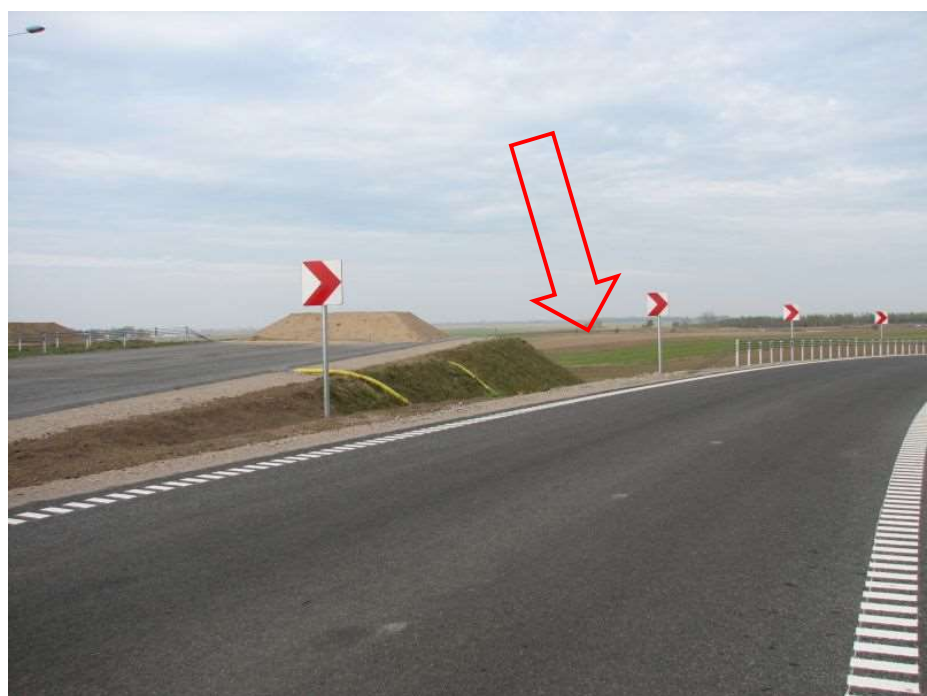
Zdjęcie 6 i 7 Wyłączenie łącznicy. Brak barier. Strome skarpy i wysoki nieosłonięty nasyp. Wypadnięcie z łuku grozi spadnięciem z nasypu.
