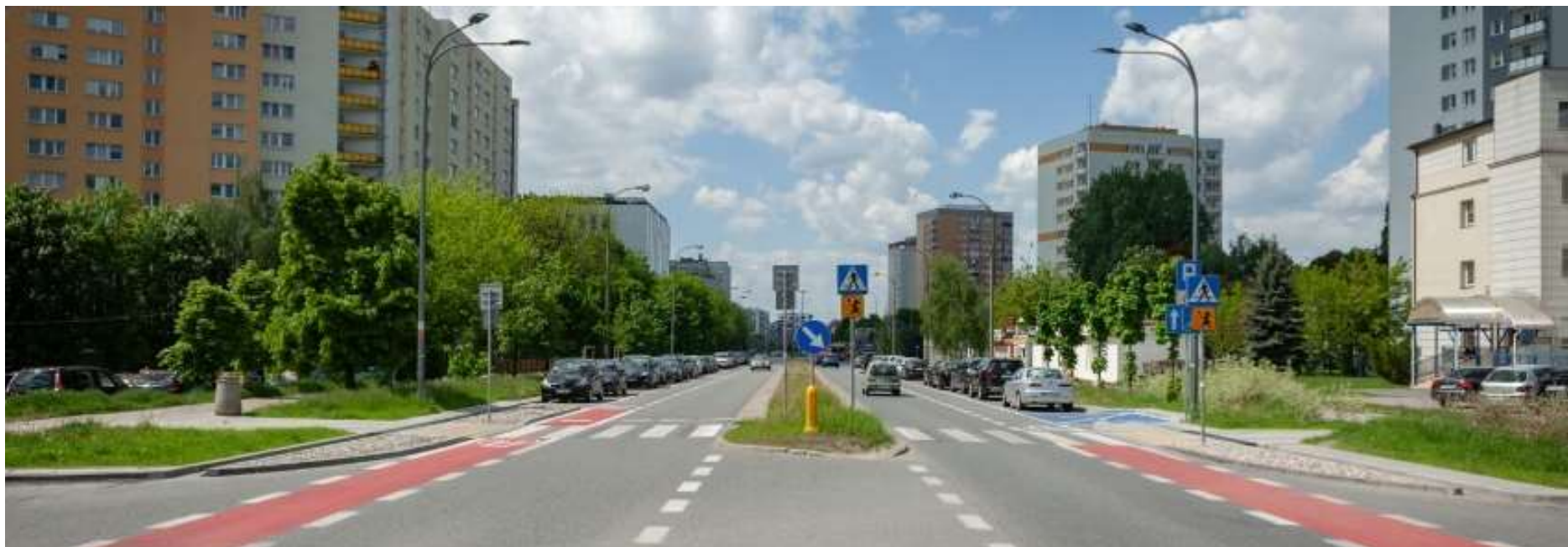
Zdjęcie 22 Widok przejść zachodnich przez ulicę Umińskiego przy skrzyżowaniu z ul. Złotej Wilgi. Źródło: Bliżej zielonej „obwodnicy” Goławia. Korzystne oferty w przetargu - Zarząd Dróg Miejskich w Warszawie (zdm.waw.pl)
