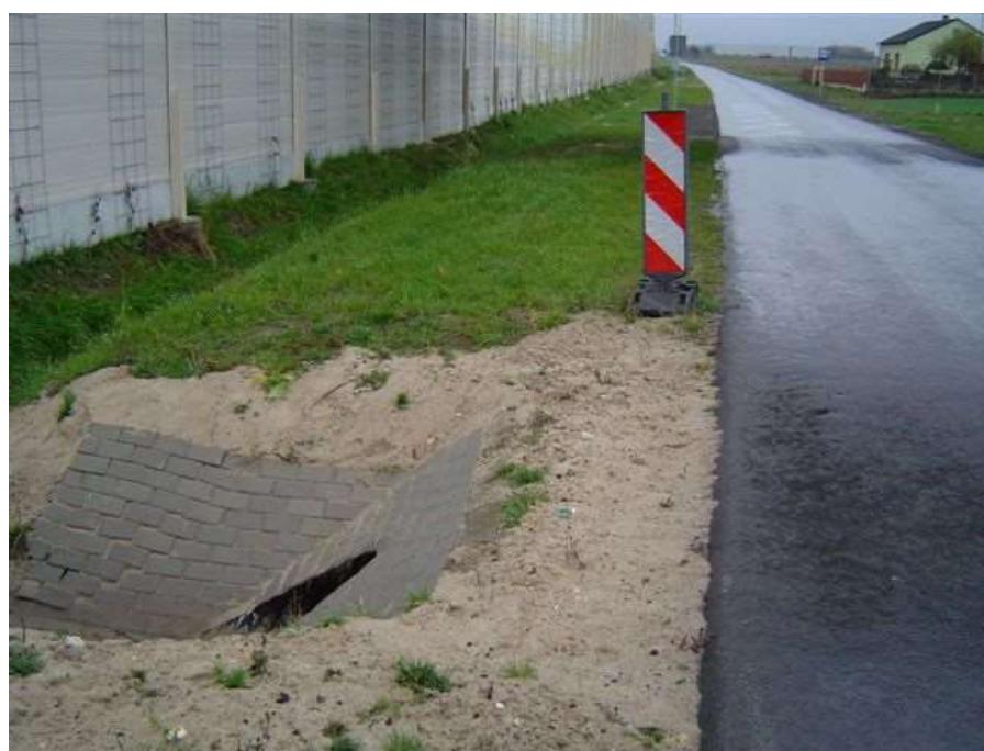
Zdjęcia 2 i 3 Nieosłonięte elementy odwodnienia
