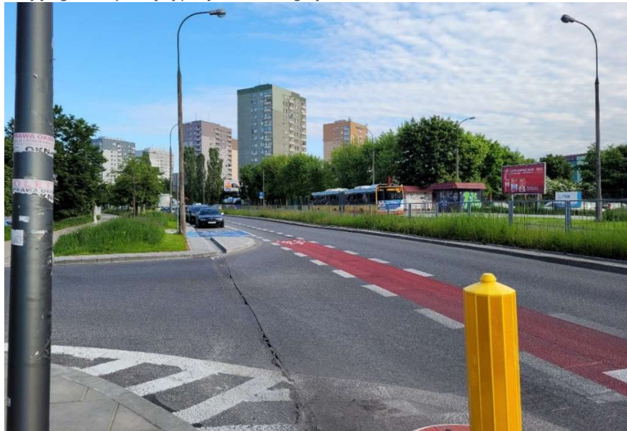
Zdjęcie 17 Widok parkujących pojazdów na dojeździe do przejścia przez jednię południową. Deficyt widoczności. Fotografia własna.
