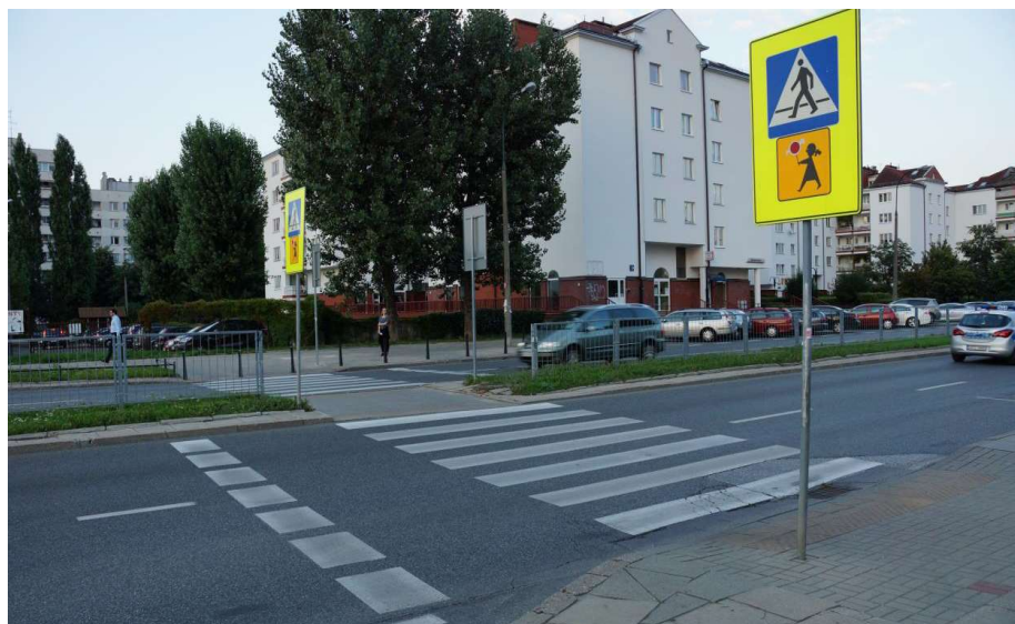
Zdjęcie 3 Widok przejścia dla pieszych przez jednię południową.
