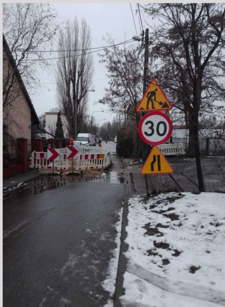
Zdjęcie 1. Oznakowanie terenu budowy.
