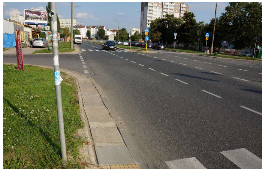
Zdjęcie 10 Widok dojazdu do przejścia dla pieszych przez jezdnię północną – strona zachodnia skrzyżowania.
