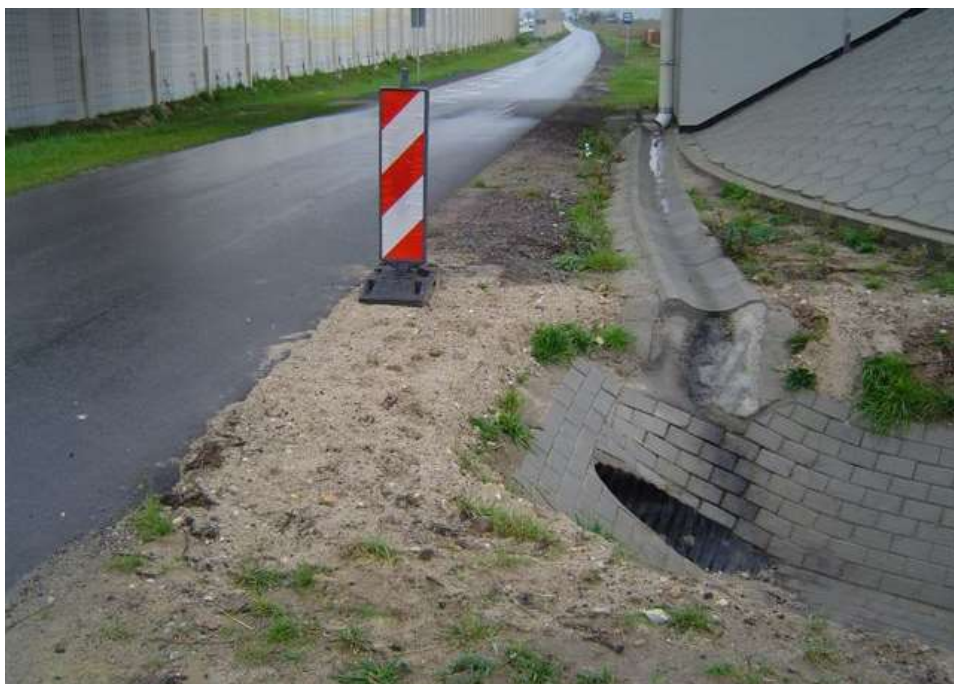
Zdjęcia 2 i 3 Nieosłonięte elementy odwodnienia
