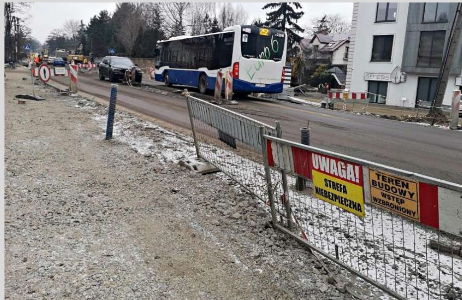
Zdjęcie 9. Komunikacja zbiorowa na terenie budowy.
