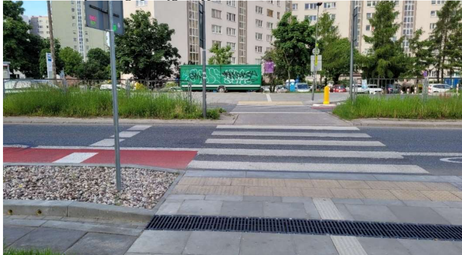
Zdjęcie 14 Widok przejścia przez jednię północną. Wysunięta platforma dla pieszych oczekujących na możliwość przejścia. Fotografia własna.
