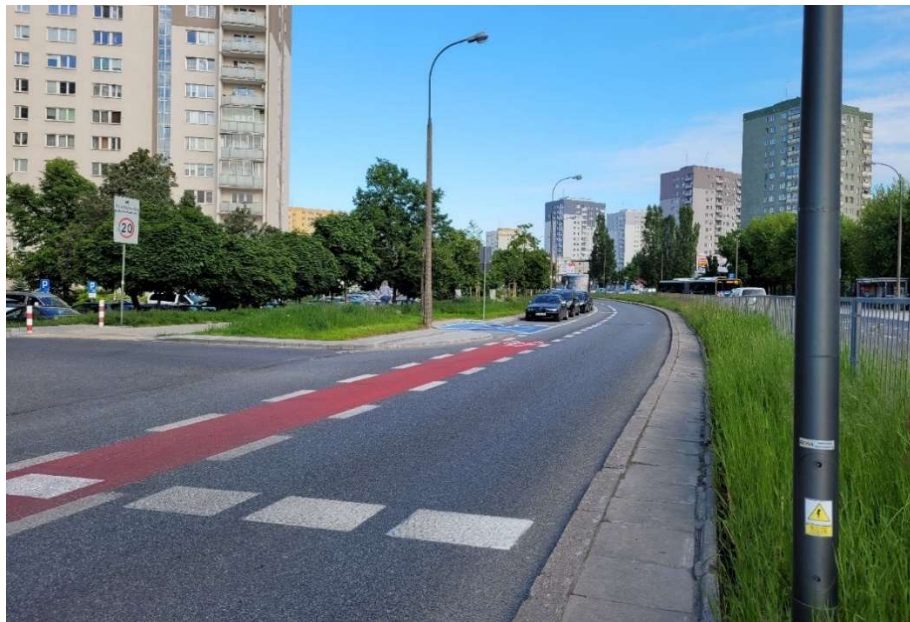
Zdjęcie 20 Przejście przez jedną południową, widok z punktu widzenia pieszego znajdującego się w pasie dzielącym. Łuk poziomy, parkujące pojazdy. Brak bufora bezpieczeństwa pomiędzy pasem rowerowym a miejscami postojowymi. Fotografia własna.
