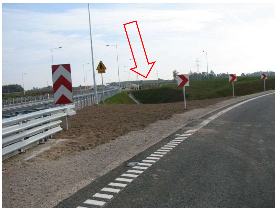
Zdjęcie 8 i 9 Wyłączenie łącznicy. Brak barier. Strome skarpy i wysoki nieosłonięty nasyp. Wypadnięcie z łuku grozi spadnięciem z nasypu.
