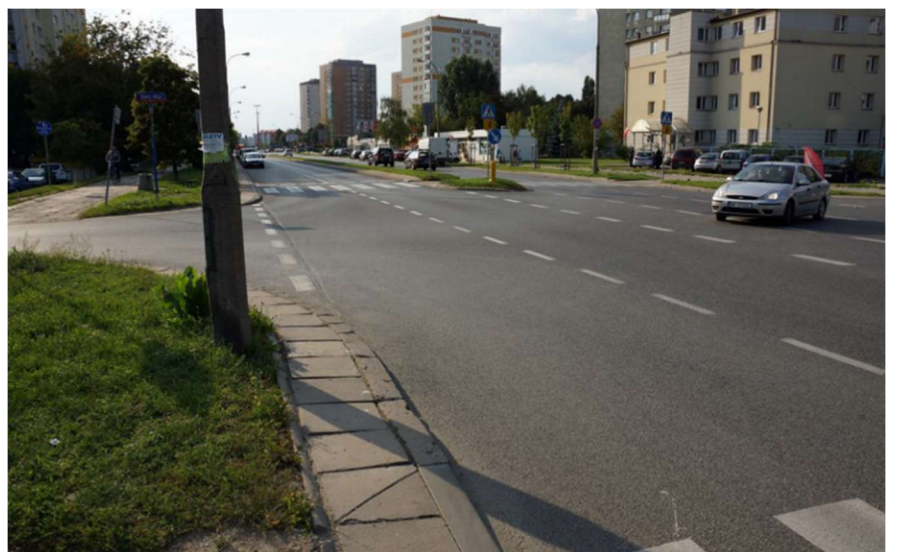
Zdjęcie 8 Widok dojazdu do przejścia dla pieszych przez jezdnię południową – strona wschodnia skrzyżowania.
