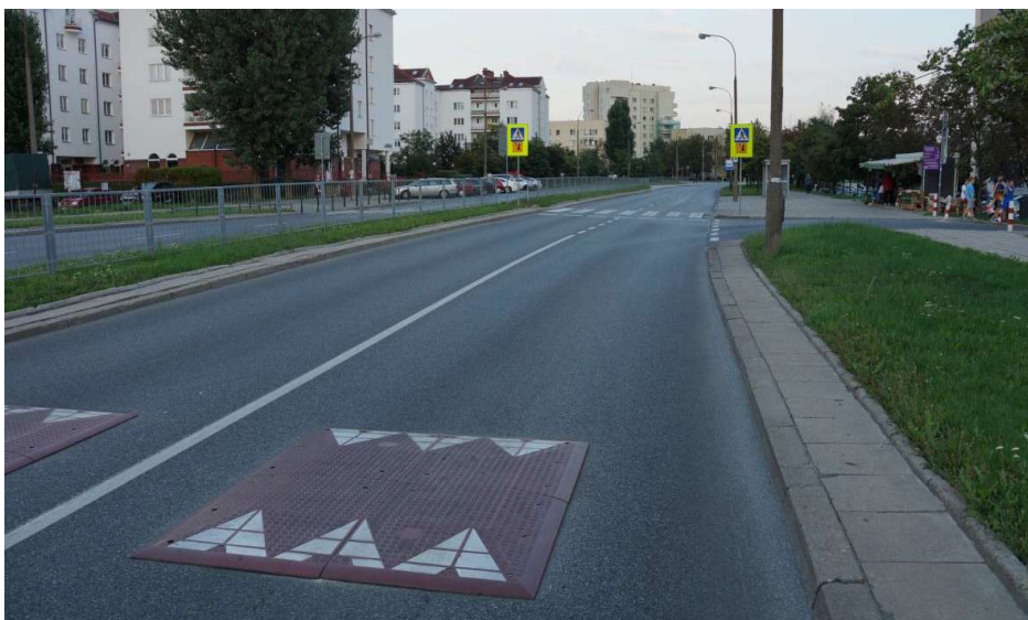
Zdjęcie 4 Widok dojazdu do przejścia dla pieszych przez jednię południową. Progi zwalniające przed przejściem.
