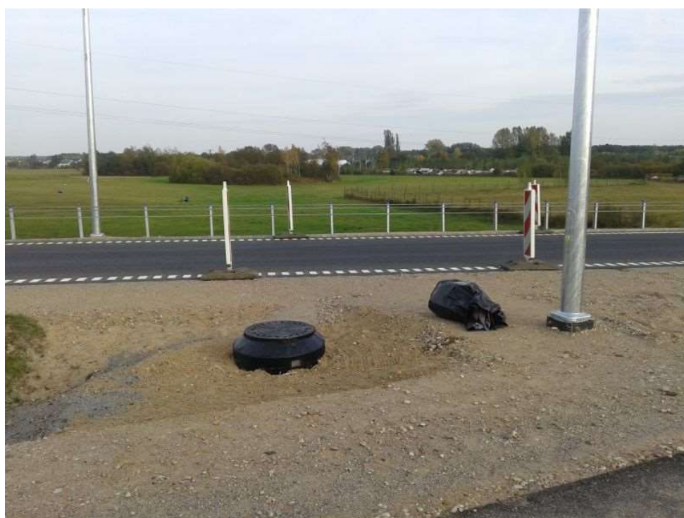
Zdjęcie 4 Nieosłonięte elementy infrastruktury na rozwidleniu łącznic.
