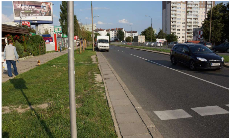
Zdjęcie 5 Przejście dla pieszych przez jezdnię północną – strona wschodnia skrzyżowania. Parkujące przed przejściem pojazdy ograniczają widoczność. Ślady parkowania tuż przed przejściem.
