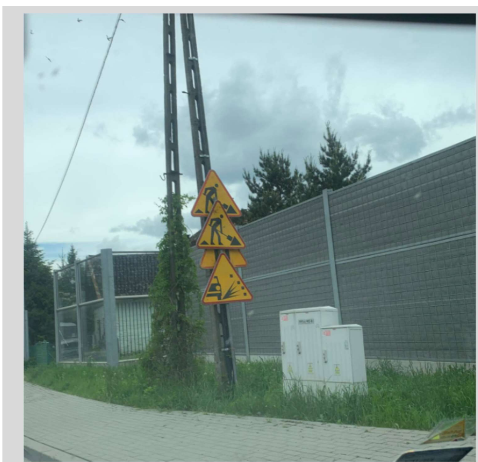
Zdjęcie 3. Oznakowanie terenu budowy.
