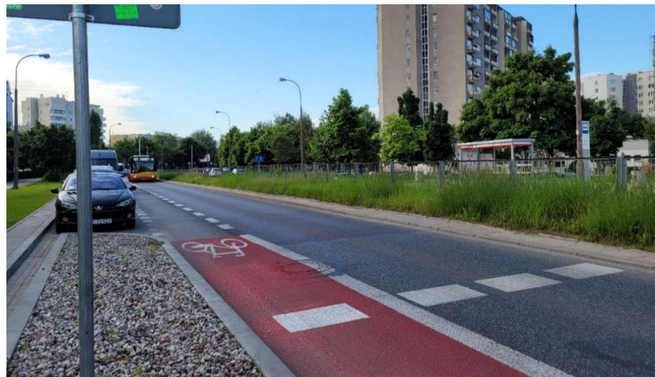
Zdjęcie 15 Widok dojazdu do przejścia przez jednię północną. Widok z punktu widzenia pieszego oczekującego na wysuniętej platformie. Fotografia własna.
