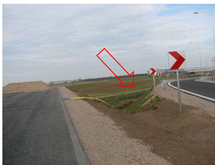
Zdjęcie 6 i 7 Wyłączenie łącznicy. Brak barier. Strome skarpy i wysoki nieosłonięty nasyp. Wypadnięcie z łuku grozi spadnięciem z nasypu.
